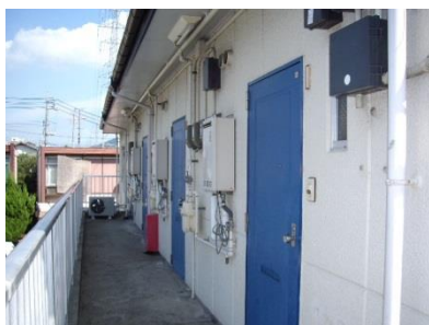
2階廊下と玄関ドア
