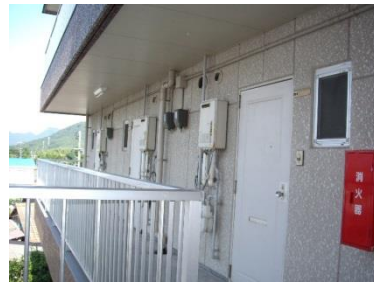
廊下部分です。台所窓。
