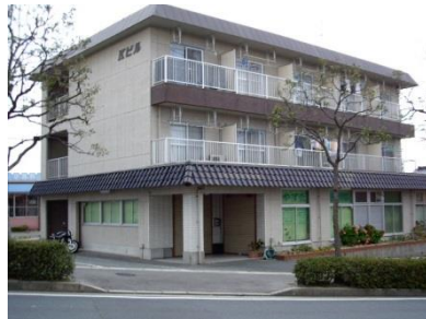
Kビル外観
